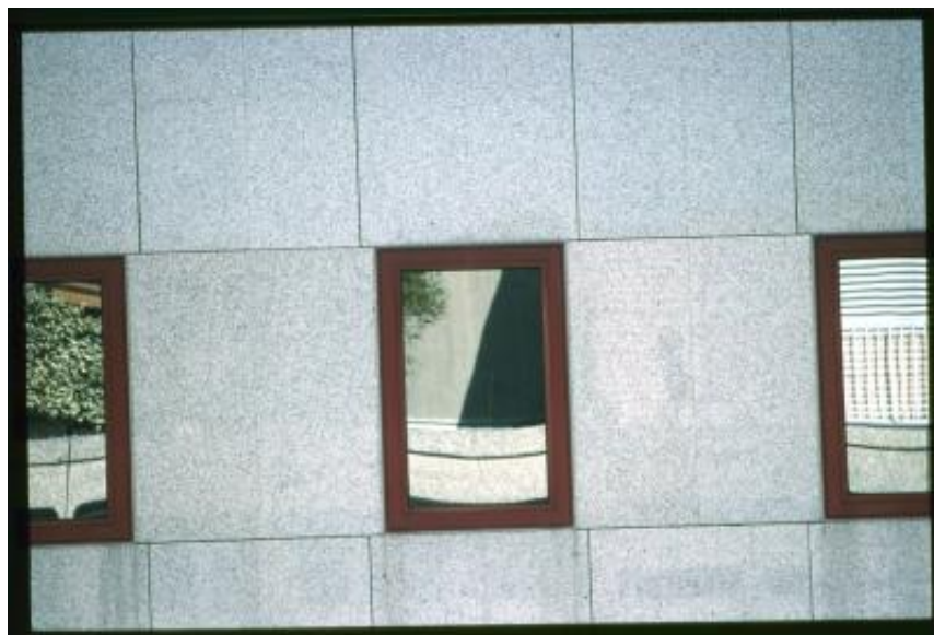
Ginevra. Dettaglio di un edificio in Rue des Battoirs
