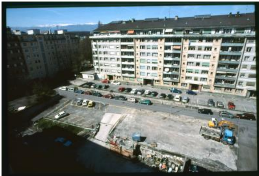
Ginevra. Cantiere edile visto da un edificio in Rue des Batoirs
