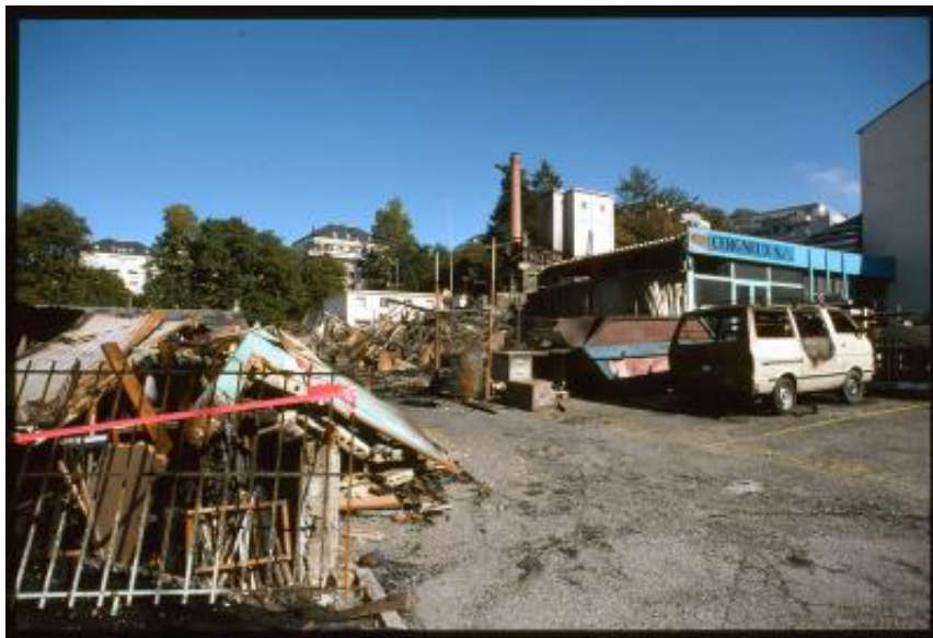
Ginevra. Detriti in Avenue Rosemont
