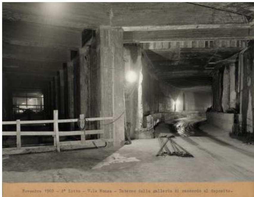
Interno della galleria di raccordo al deposito in viale Monza a Milano
