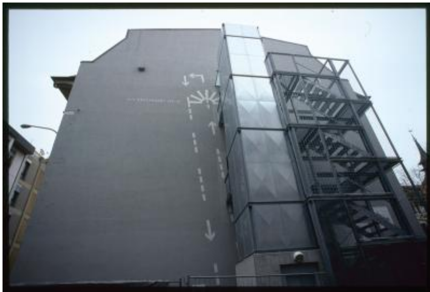
Ginevra. Ascensore esterno in Rue Rodo
