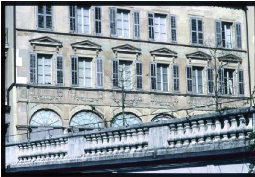
Ginevra. Facciata di un edificio in Rue des Granges
