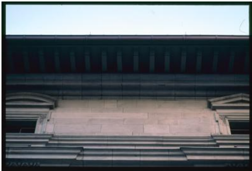
Ginevra. Dettaglio della grondaia della Maison Turretini
