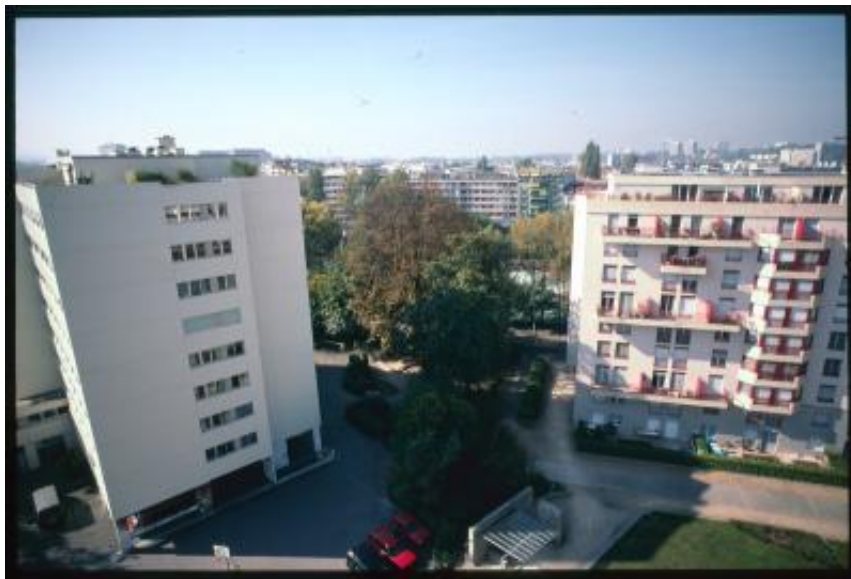
Ginevra. Edifici visti dal tetto della scuola materna del quartiere di Plainpalais
