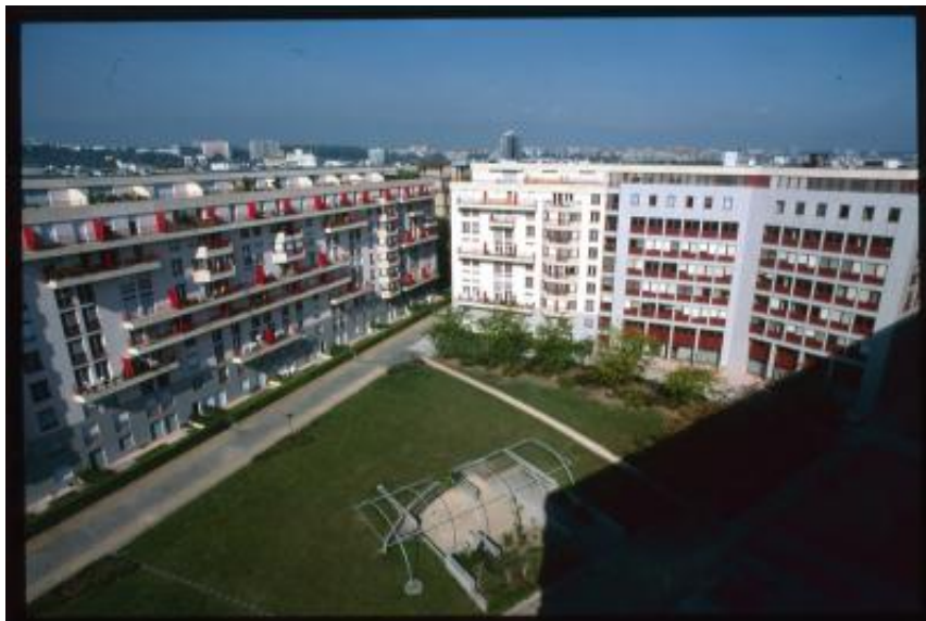
Ginevra. Parc des Minoteries visto dal tetto della scuola materna di Plainpalais
