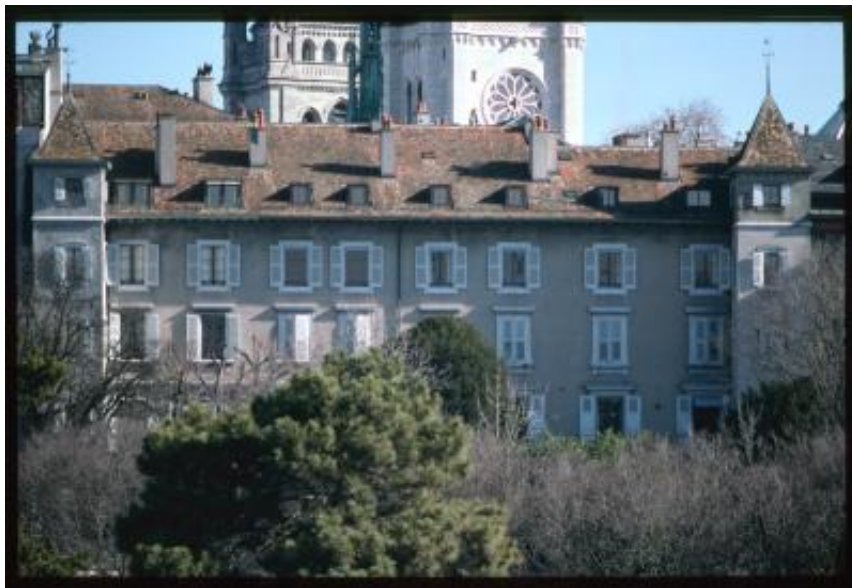
Ginevra. La Maison Turretini vista dal tetto di Uni-Bastions
