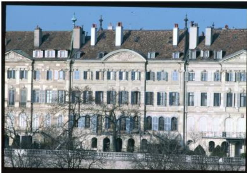
Ginevra. Maison Boissier-Dominicé vista dal tetto di Uni-Bastions
