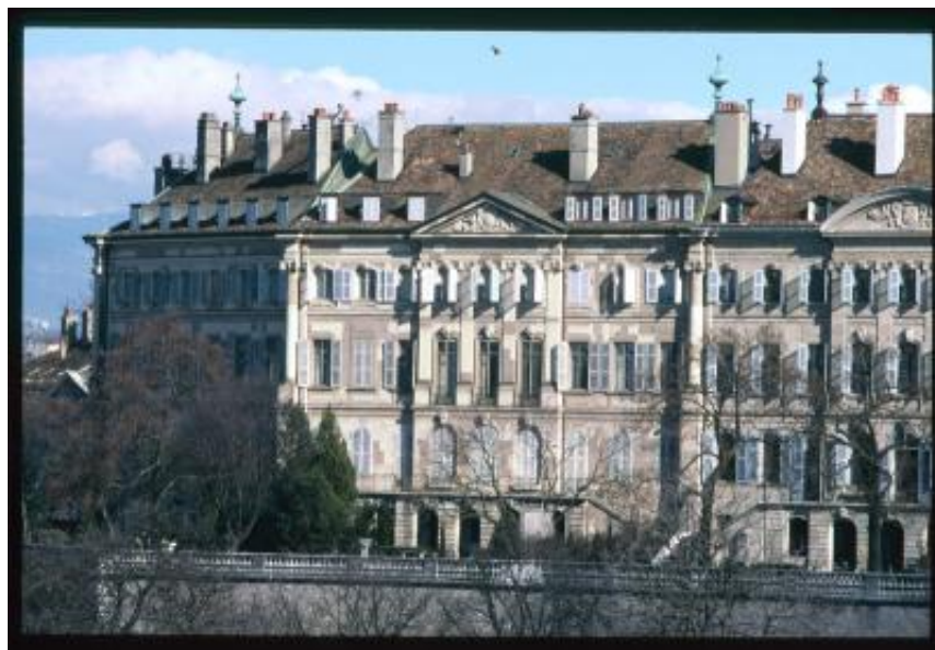
Ginevra. L'Hôtel Sellon visto dal tetto di Uni-Bastions
