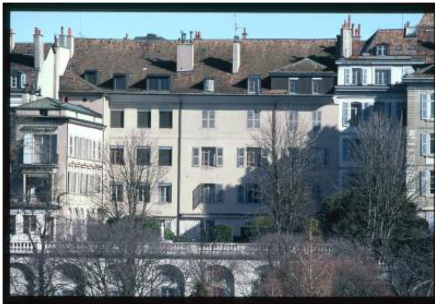
Ginevra. Palazzo in Rue des Granges visto dal tetto di Uni-Bastions
