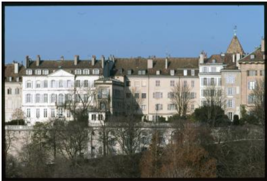
Ginevra. Palazzi in Rue des Granges visto dal tetto degli Uni-Bastions
