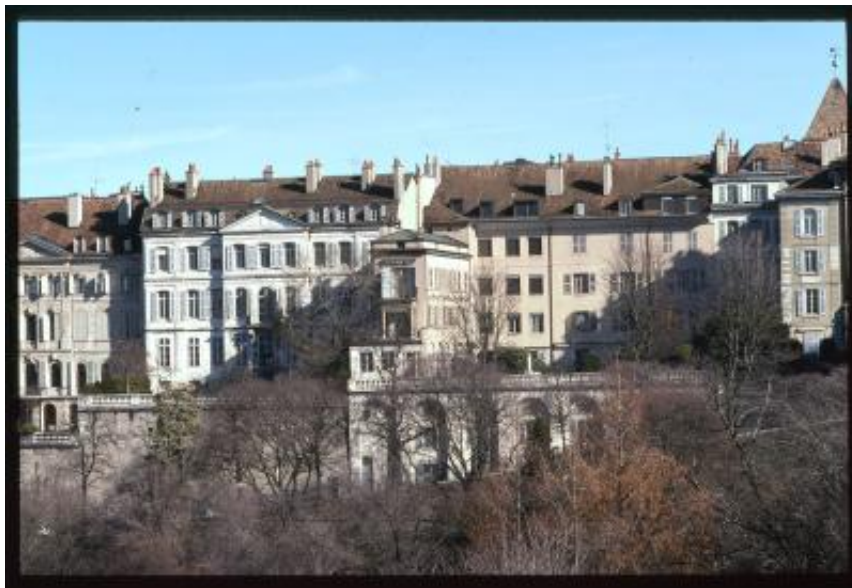
Ginevra. Palazzi in Rue des Granges visto dal tetto degli Uni-Bastions
