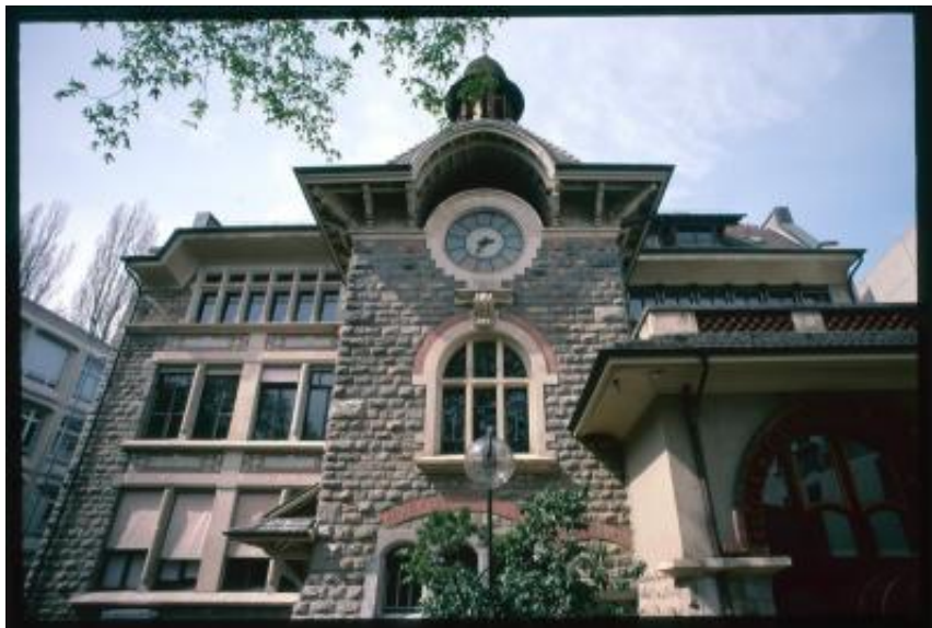
Ginevra. Dettaglio di una facciata dell'École Hugo-De-Senger
