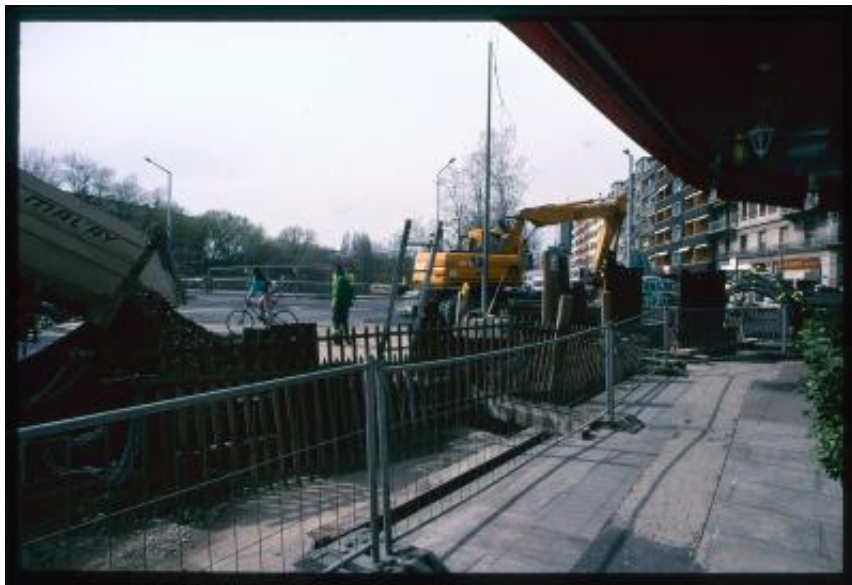
Ginevra. Lavori stradali all'angolo fra Quai Charles-Page e Boulevard du Pont d'Arve
