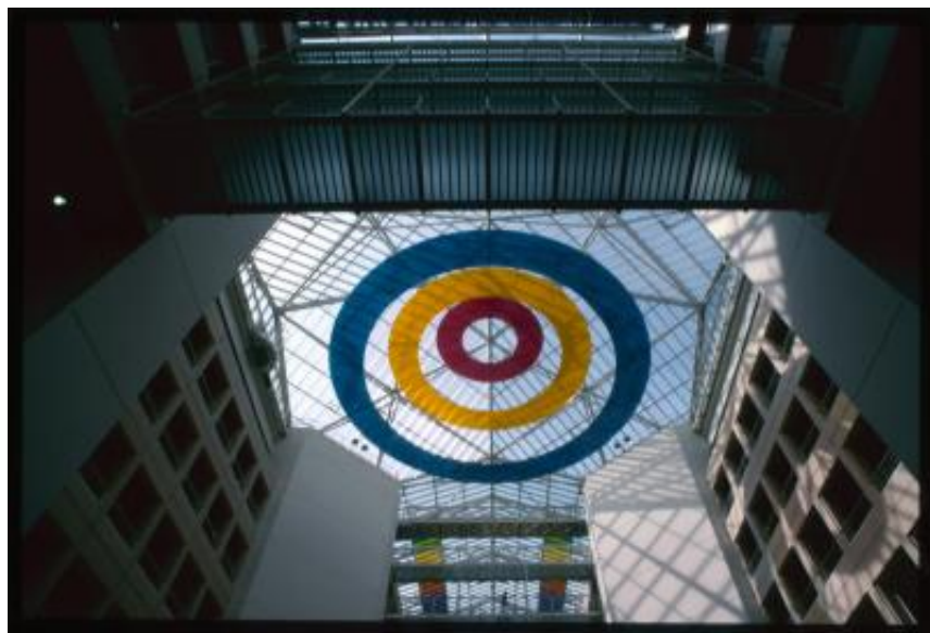
Ginevra. Dettaglio del soffitto dell'Uni-Mail visto dall'interno
