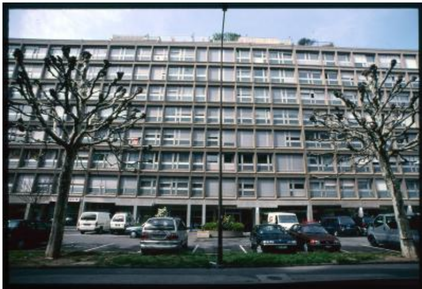
Ginevra. Facciata di un palazzo in Rue des Batoirs
