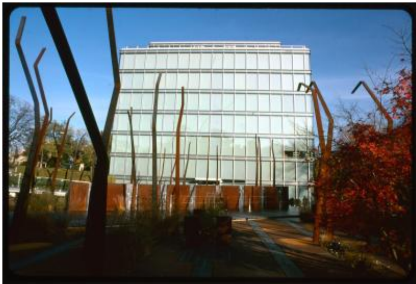
Ginevra. Facciata di un edificio in Avenue de l'Amandolier
