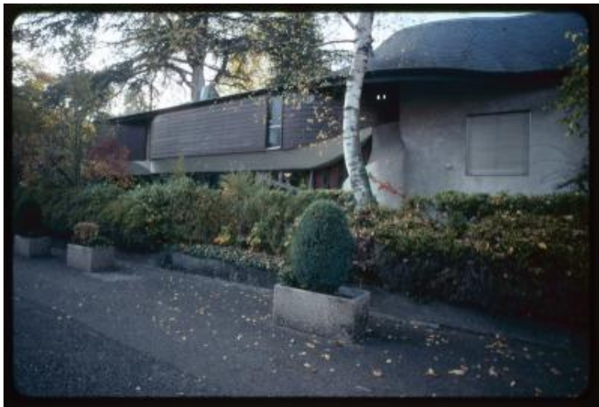
Ginevra. Facciata di una casa in Rue Agasse
