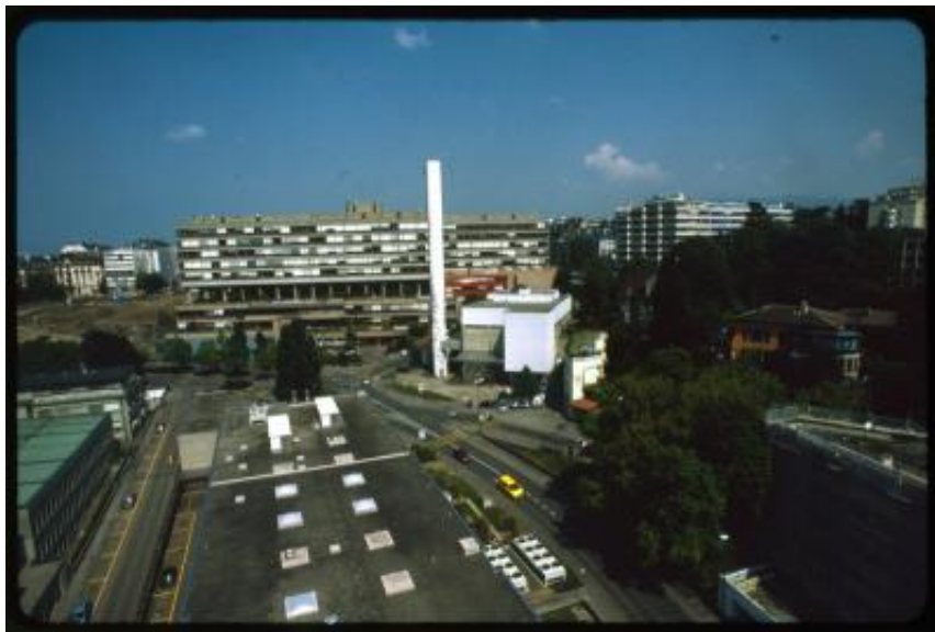
Ginevra. Veduta dal decimo piano dell'Ospedale Universitario verso est
