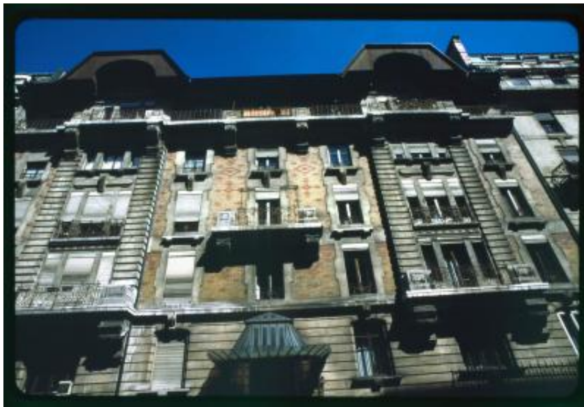
Ginevra. Facciata di un palazzo in Rue Emile-Yung
