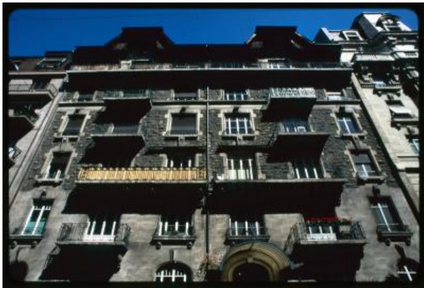
Ginevra. Facciata di un palazzo in Rue Emile-Yung
