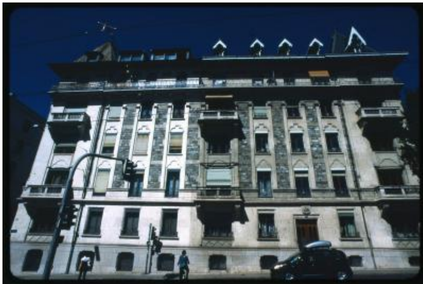
Ginevra. Facciata di un palazzo in Route de Chêne
