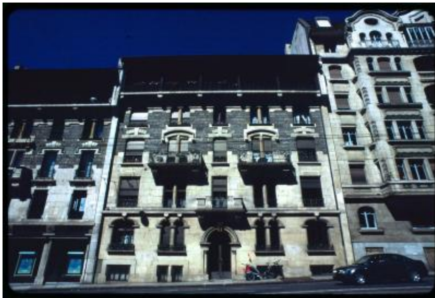
Ginevra. Facciate dei palazzi in Route de Chêne
