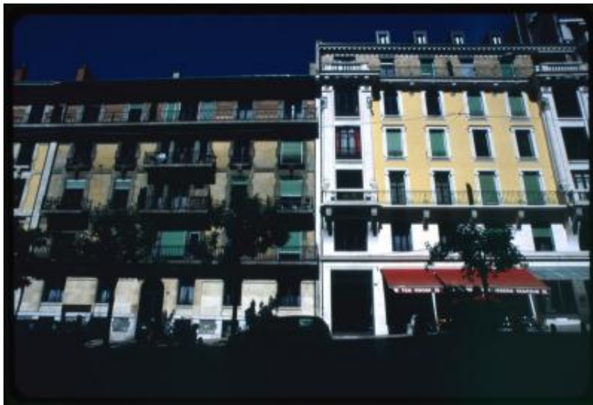
Ginevra. Facciate dei palazzi in Avenue Pictet-de-Rochemont
