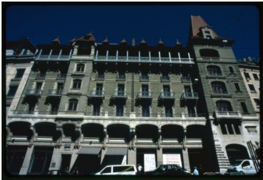
Ginevra. Facciata di un palazzo in Rue de la Corraterie
