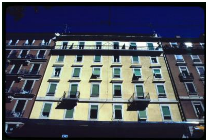
Ginevra. Facciata di un palazzo in rue de Carouge
