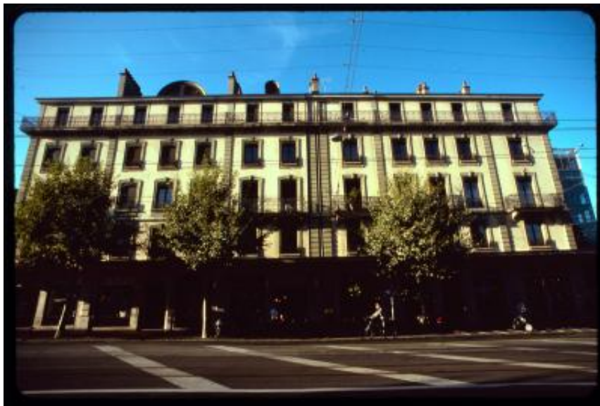
Ginevra. Facciata di un palazzo in Cours de Rive
