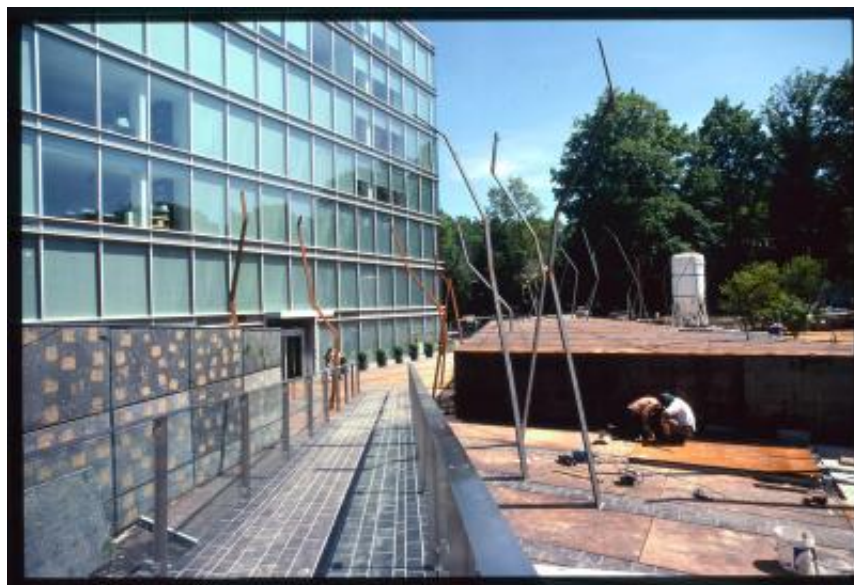
Ginevra. Palazzo in costruzione in Avenue de l'Amandolier
