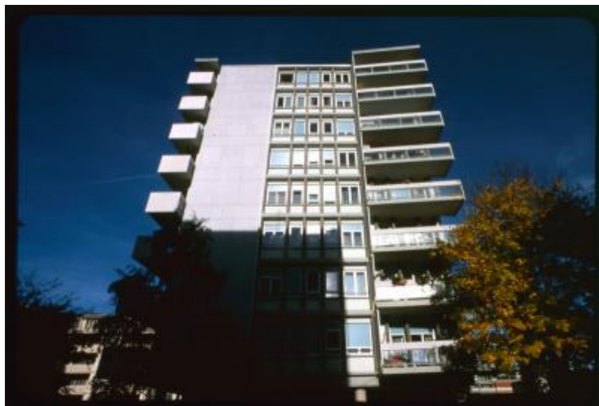
Ginevra. Edificio in rue des Cordiers
