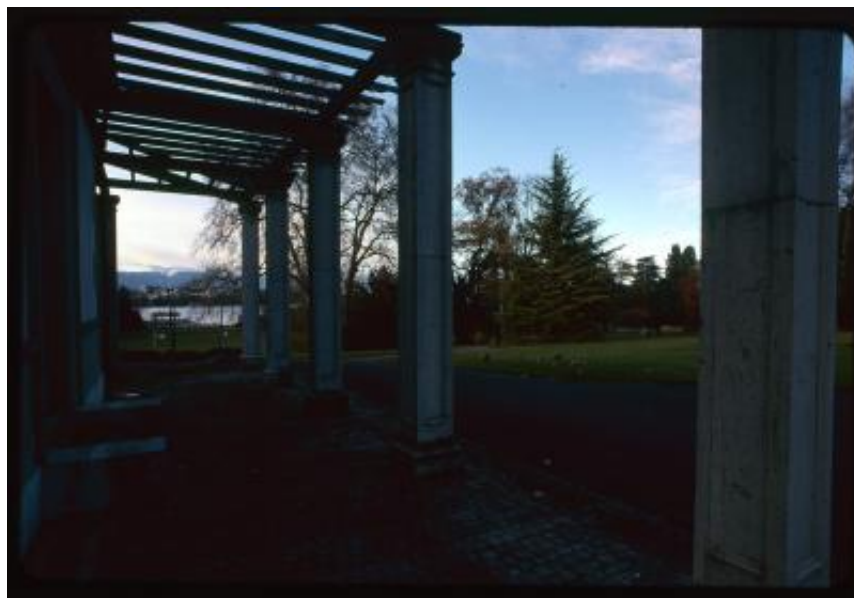
Ginevra. Porticato di Villa la Grange
