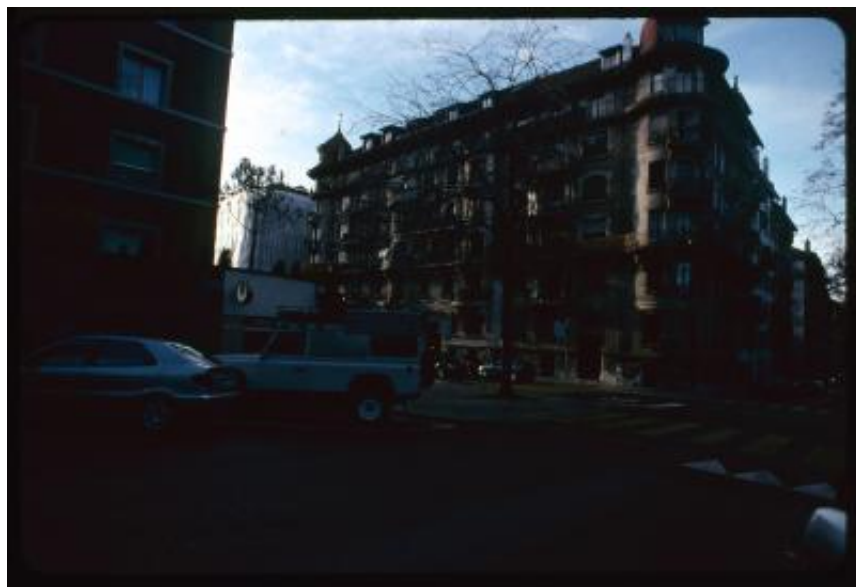
Ginevra. Complesso residenziale di Montchoisy, all'angolo tra Montchoisy e William Favre
