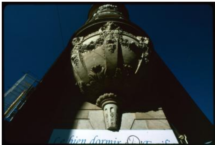
Ginevra. Dettaglio del balcone del palazzo tra rue du Roveray e rue des Eaux-Vives
