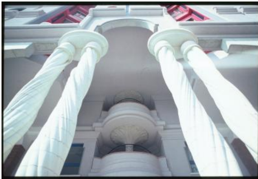
Ginevra. Ingresso del palazzo Il di Les Schtroumpfs da rue du Grand Pré
