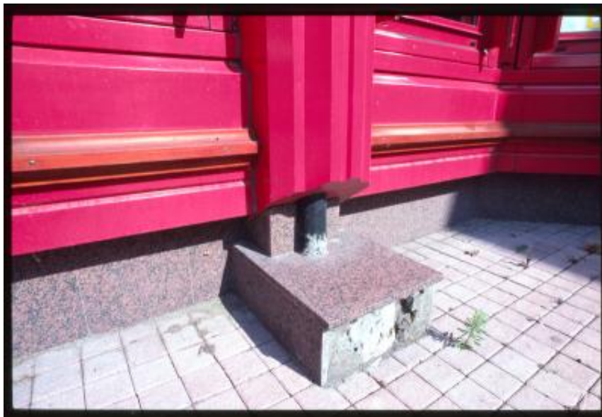
Ginevra. Dettaglio del canale di scolo del palazzo II di Les Schtroumpfs
