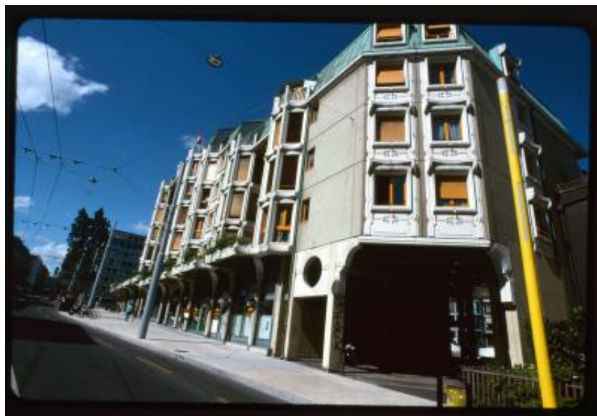
Ginevra. Facciata di un palazzo affacciato su rue de la Servette
