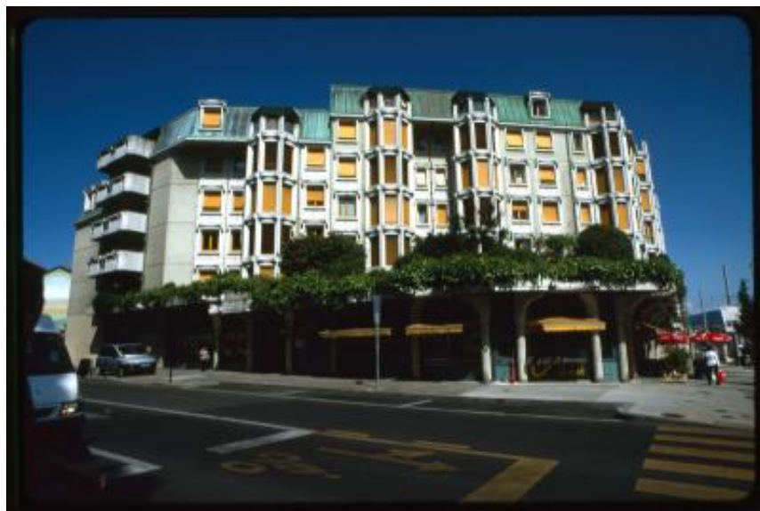
Ginevra. Veduta dello stabile Koechlin dall'incrocio tra rue Louis Favre e rue de la Servette
