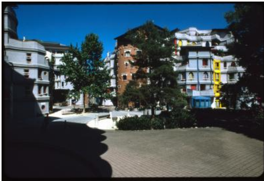
Ginevra. Facciata del palazzo II di Les Schtroumpfs
