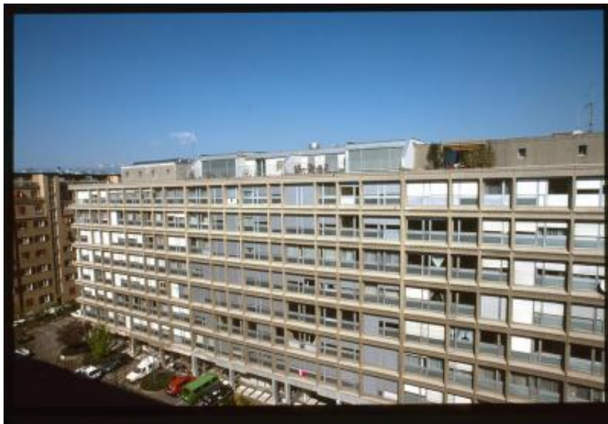
Ginevra. Facciata di un edificio in rue des Battoirs
