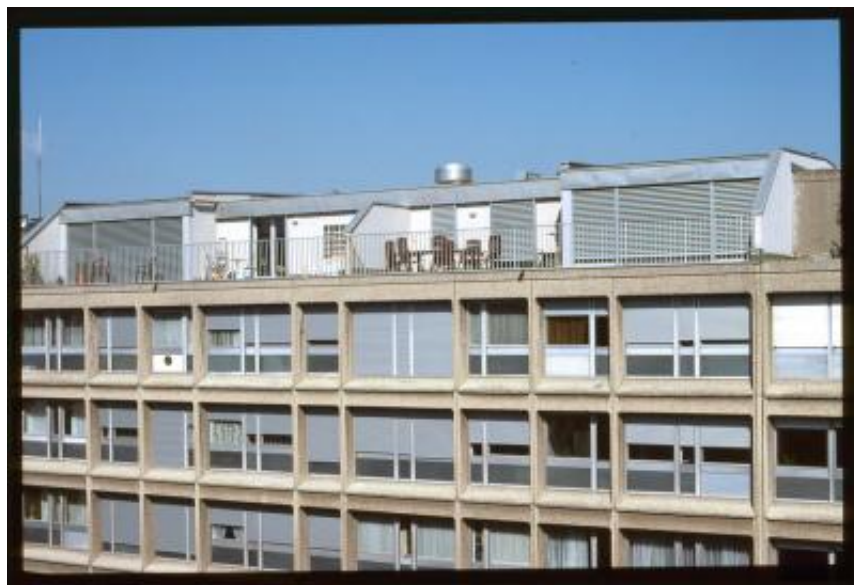
Ginevra. Dettaglio della facciata di un edificio in rue des Battoirs
