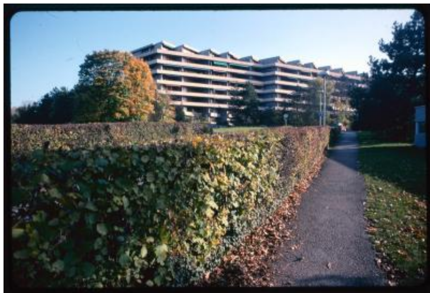
Le Grand-Saconnex. Veduta di alcuni edifici dal lato del giardino
