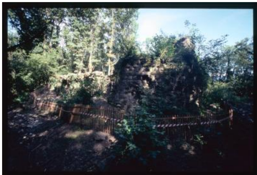
Meinier. Dettaglio di un muro delle rovine del castello di Rouelbeau
