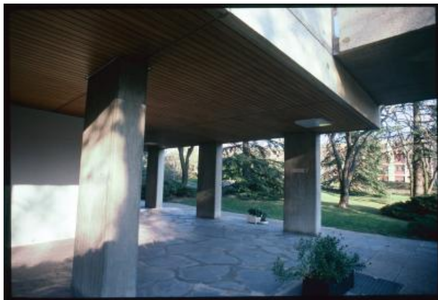
Thônex. Dettaglio dei pilastrini del Residence Apollo
