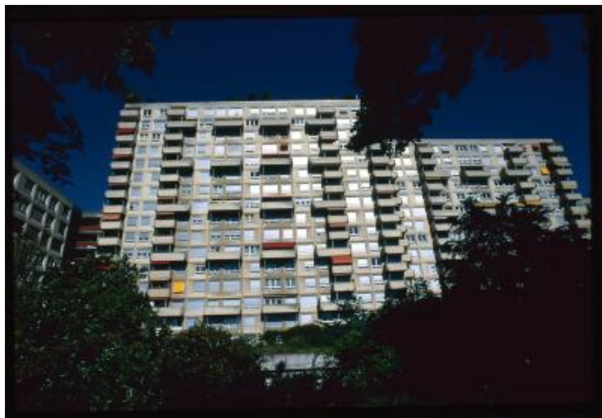
Thônex. Facciata del Résidence Apollo vista frontalmente
