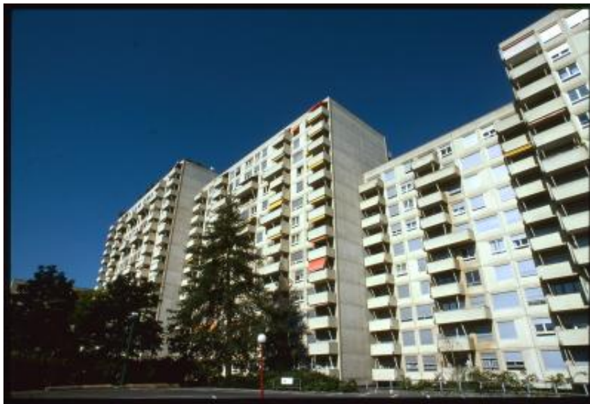
Thônex. Facciata del Résidence Apollo vista lateralmente
