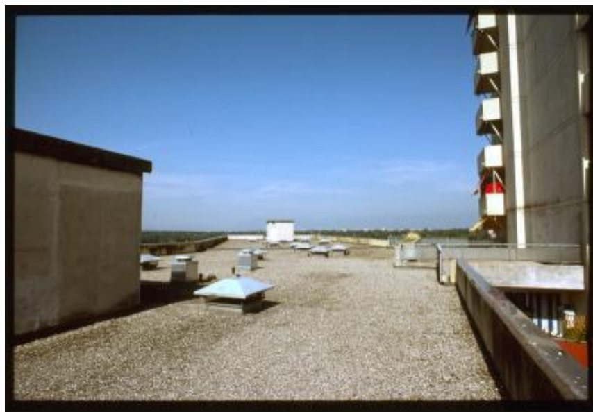
Thônex. Tetto del Résidence Apollo
