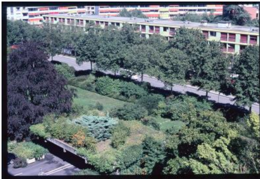
Thônex. Garage sotterraneo visto dal balcone di un edificio
