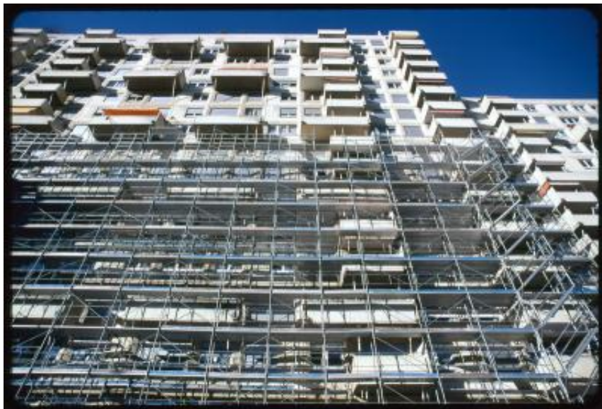
Thônex. Lavori di rifacimento alla facciata del Résidence Apollo
